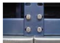
Detalles del montaje
