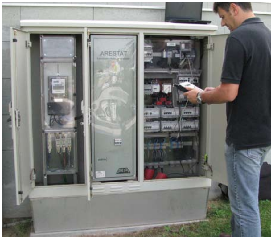
Reparación, ajuste y reprogramación de instalaciones
